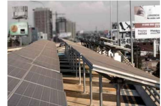
Sistema Fotovoltaico interconectado a la red de CFE para el suministro de energía que utilizan las luminarias.
