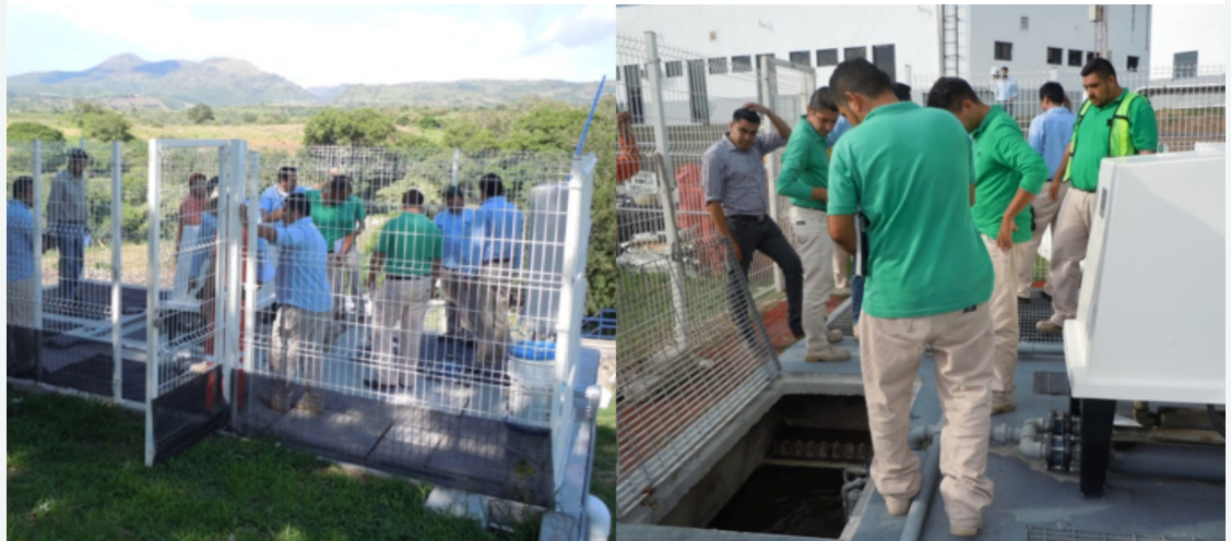
Durante el curso de reforzamiento del mantenimiento a la PTAR.
