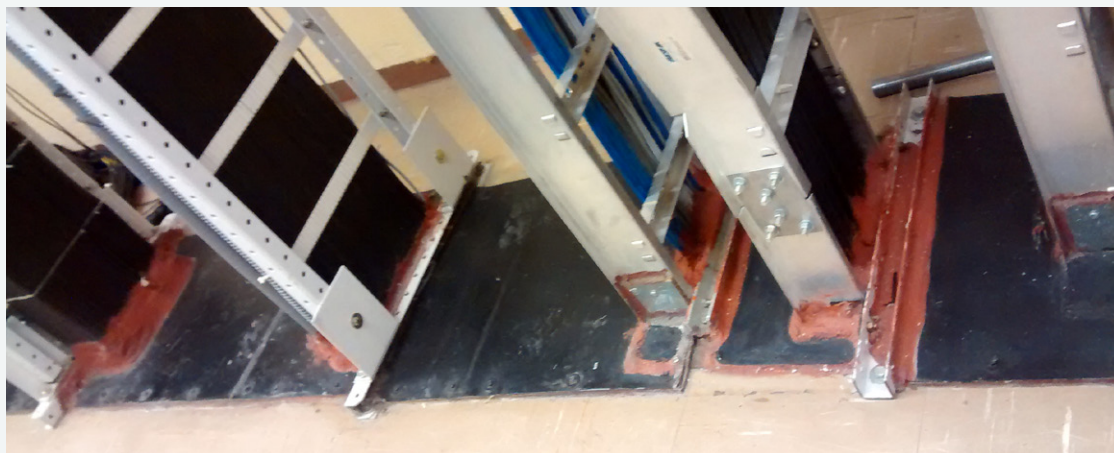
Sello de paso de cables para evitar que se fugue el aire acondicionado.
